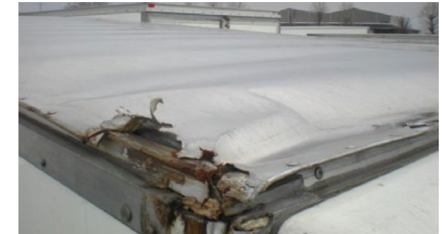
Dakruimte: Frame beschadigd, leer te ver beschadigd dat reparatie niet economisch verantwoord is
