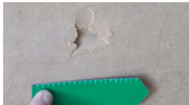
Houten binnenbekleding: Kleine deuken
