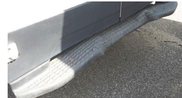
Treepanken achter: Economisch niet verantwoord te repareren vervormingen
