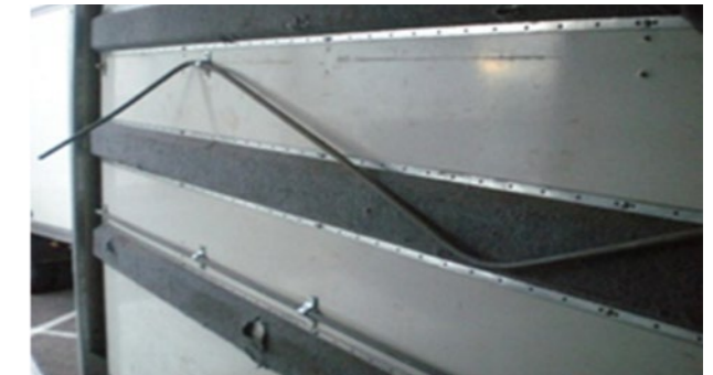
Bekleding en stangen: Stangen, bevestigingen, bekleding ontbreken of vervormd, reparatie niet meer economisch verantwoord
