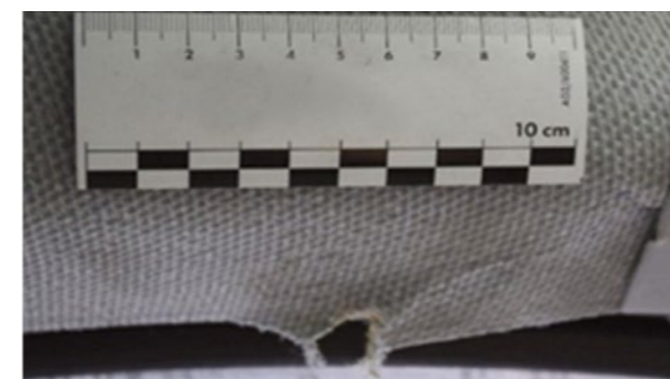
Stoffen bekleding: Scheur, gat > 5 mm, onuitwisbare vlekken
